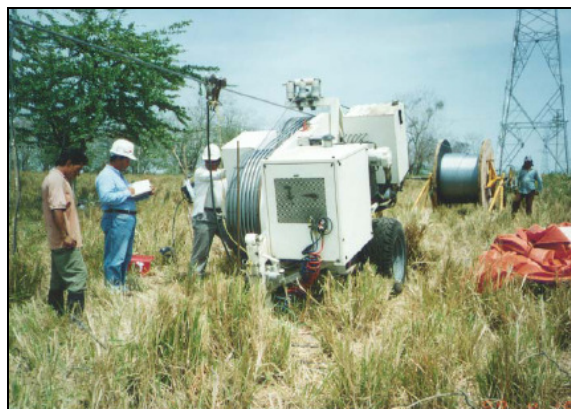
Foto 2.2-1 Maquinaria empleada para el tendido del conductor 2
