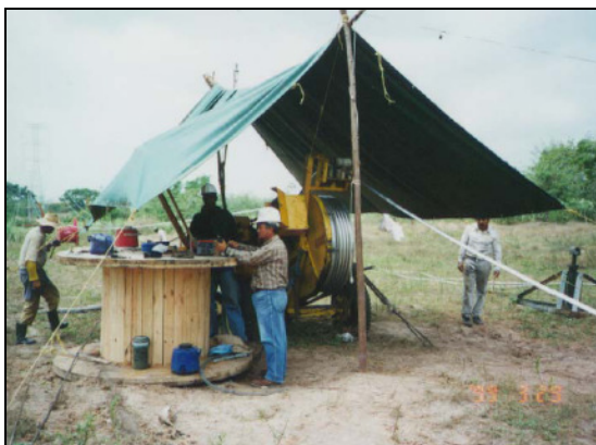
Foto 2.2-1 Maquinaria empleada para el tendido del conductor 2
